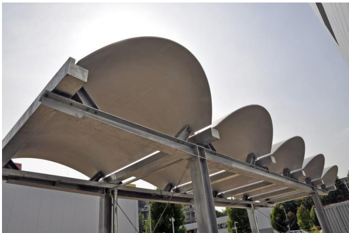
Grafik 1 Fahrradüberdachung aus Carbonbeton (Foto: ITA)
